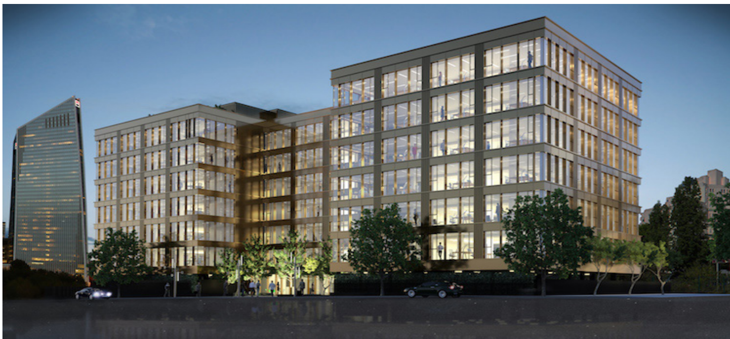
Le 132 rue des Trois Fontanot, à Nanterre © Artea
