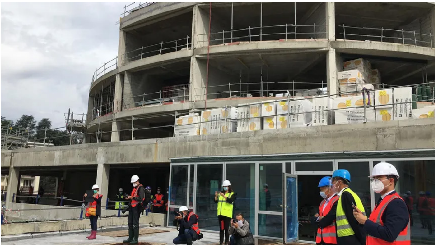
La terrasse du 6ème étage du bâtiment, toujours en pleine rénovation © Radio France - MC
